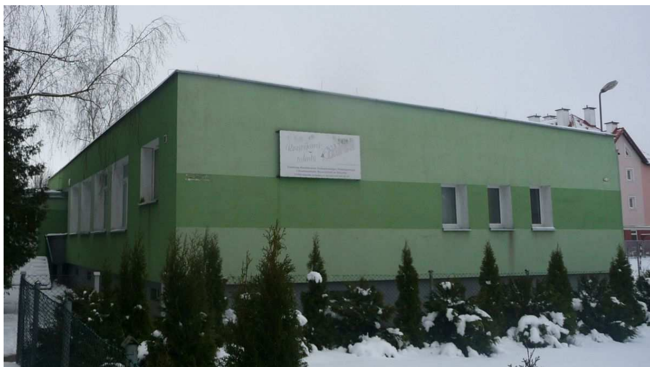
Zdjęcie nr 2. Widok elewacji szczytowej
