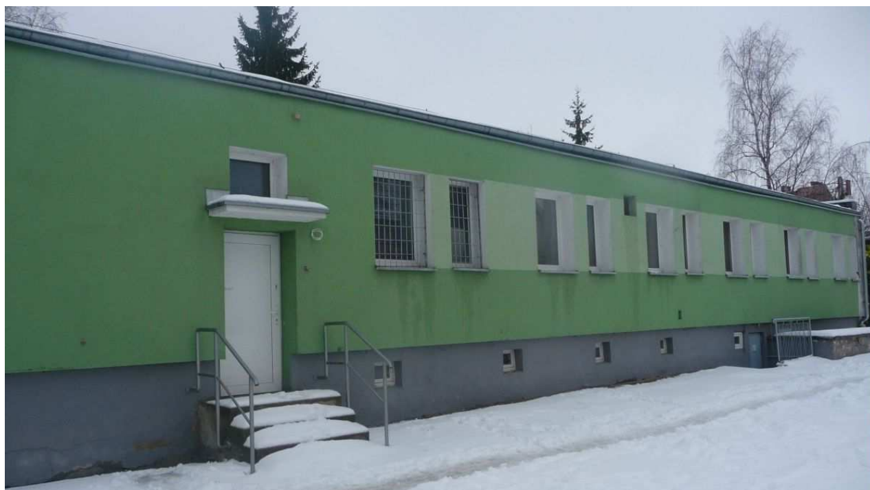
Zdjęcie nr 1. Widok elewacji frontowej
